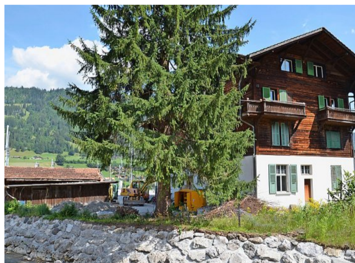
Blick auf das ehemalige und heute leer stehende Wohnhaus Hotel Bristol. Die Garagenbox (l.) und die Tanne müssen den Hochwasserschutzmassnahmen weichen. Foto: Fritz Leuzinger
