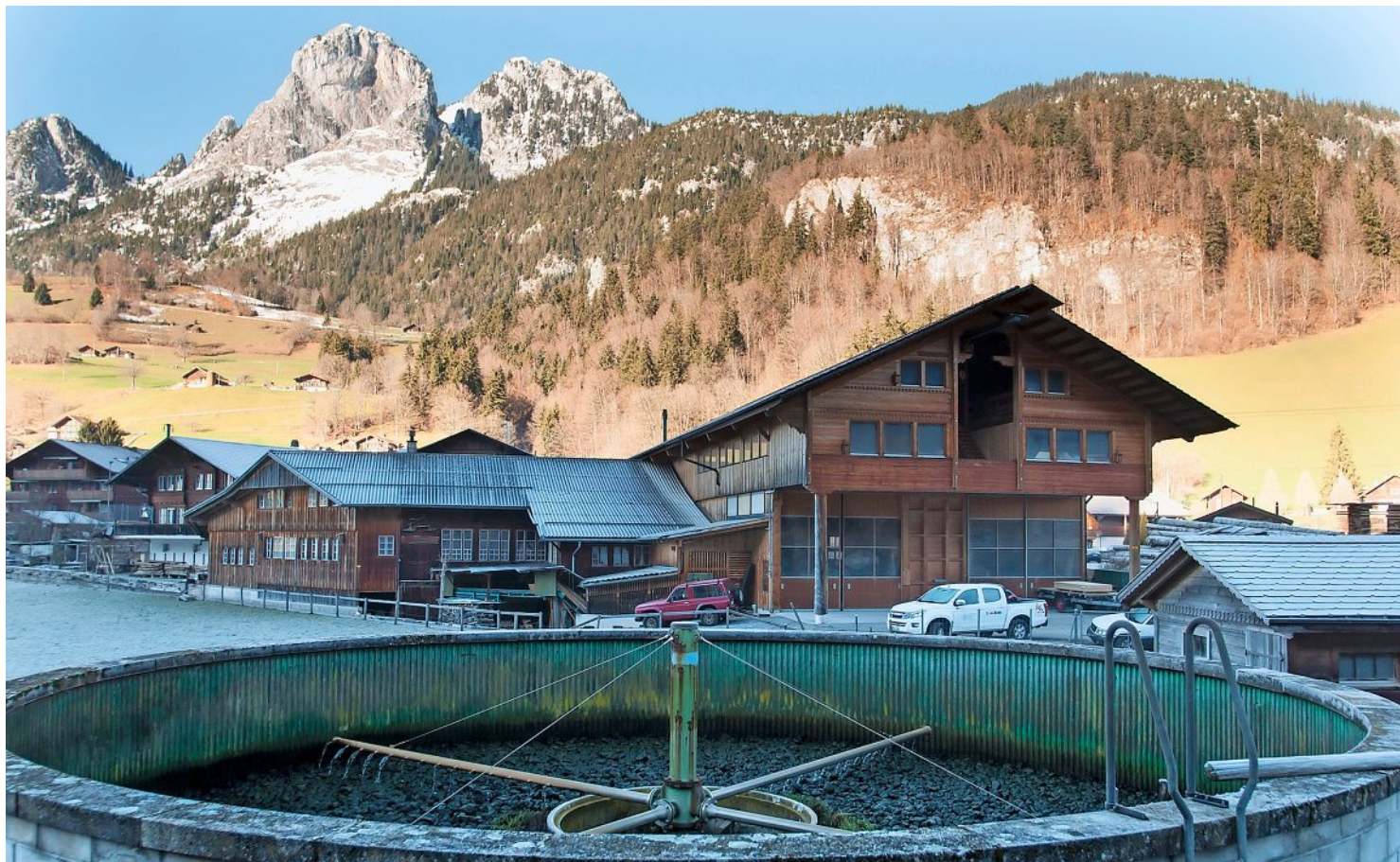
Ihre Tage scheinen gezählt: Die alte ARA in Boltigen dürfte schon bald zurückgebaut werden. Foto: Kerem S. Maurer
