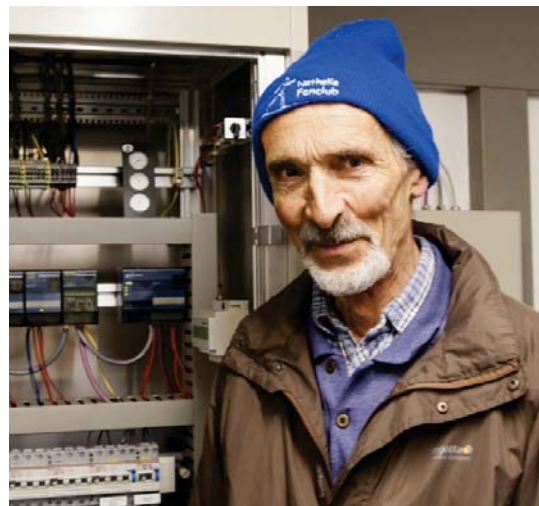
Martin Humm betreibt sein Kleinstwasserkraftwerk seit 1996.
